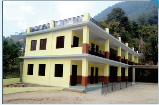
पुनर्निर्माण प्राधिकरणको आर्थिक तथा प्राविधिक सहयोगमा निर्मित विद्यालयको भवन
